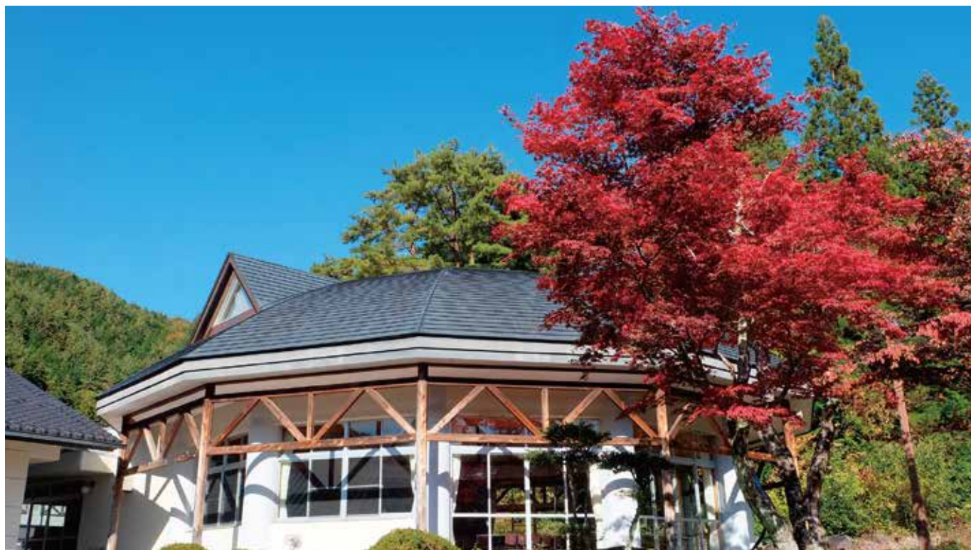
木曾郡上松町立上松中学校
